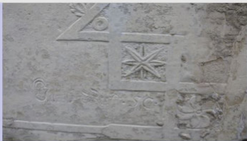
Abb. 4 Die rechte untere Ecke des Epitaphs zeigt noch schwach den Namen des Bildhauers „Jakob Ross sc(ul)ptor“. Die Verwitterungsschäden sind deutlich zu erkennen
